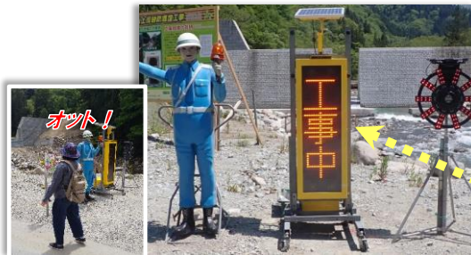
【写真-13 現場入口にもガードマンロボ】
