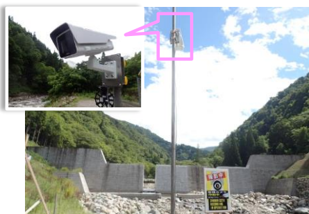
【写真-7 現場場内に設置したカメラ】
