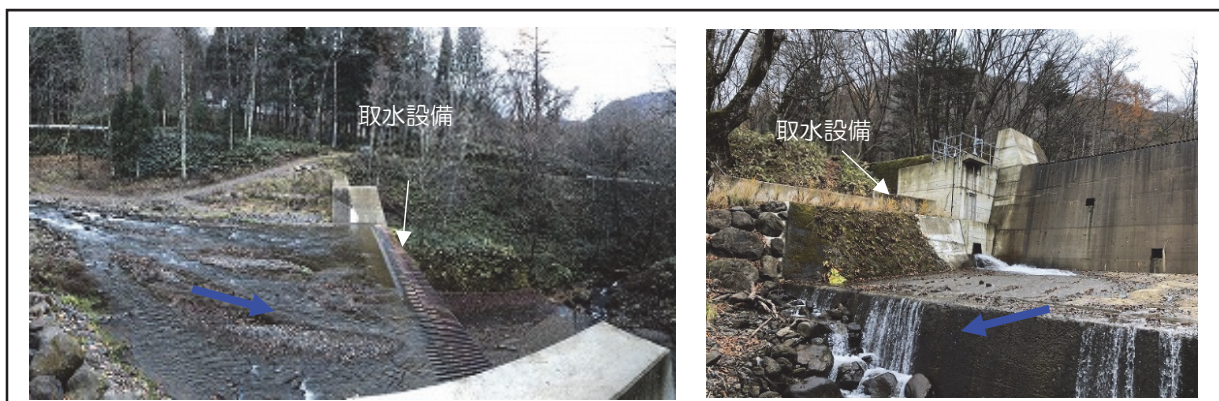
図-2 砂防堰堤を利用した小水力発電施設の調査箇所（取水設備の調査の例）
