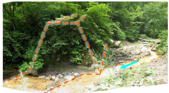
調査対象の堰堤の堆砂域を望む。 堆砂域は満砂状態である。
