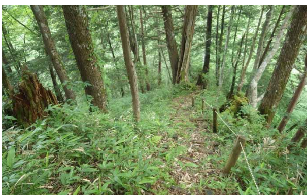
丸太階段の様子。尾根に沿って設置されており、柵となる杭とロープの一部が不安定な状態である。
