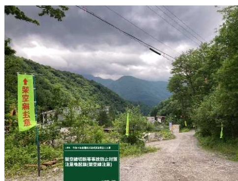
〔写真-9〕 のぼり旗（↑架空線注意）設置
