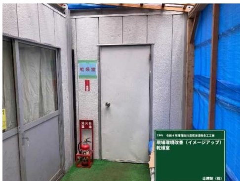
〔写真-4〕乾燥室（外観）
