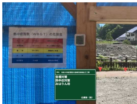
〔写真-7〕 みはりん坊設置
