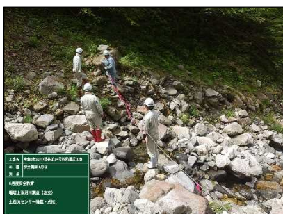
土石流センサー点検状況
