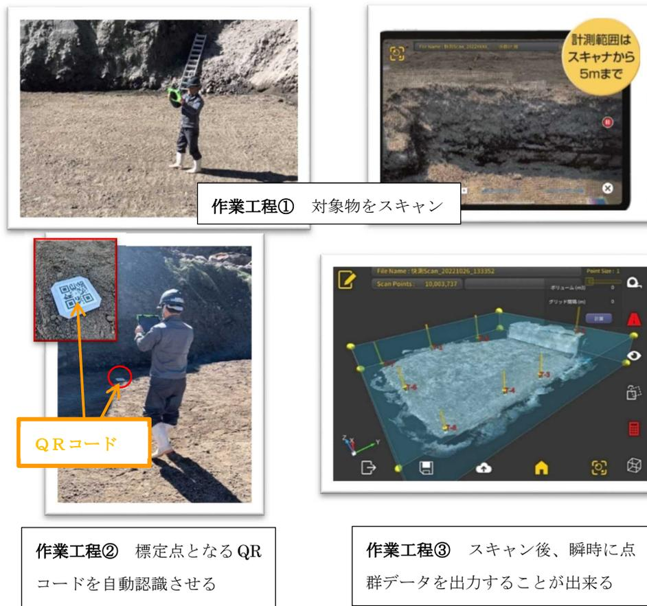
【効果①】従来のUAV測量では、標定点測量、ドローン空撮、点群処理に約5時間かかっていたが、標定点測量15分、スキャンによる点群作成15分、合計30分での測量が可能となり生産性が格段に向上した。
