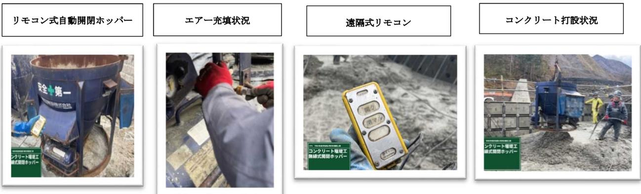
【効果①】従来はホッパー係として1名作業員を配置していたが、遠隔リモコン式自動ホッパーによりバイブレーターをかけながらのリモコン操作が可能となり、作業員1名の省人化となった。
