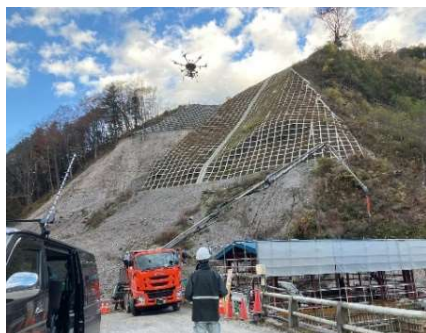
【 3次元技術を用いた出来形計測状況 】
