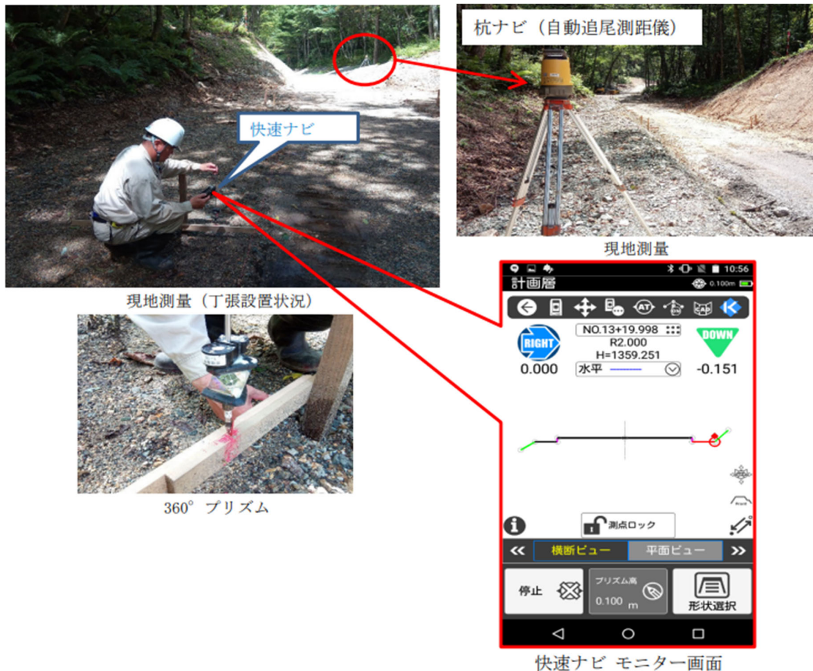
3次元データを使用した測量例
