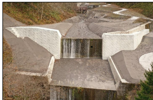
写真-2 白谷第1号砂防堰堤 今年度完成
