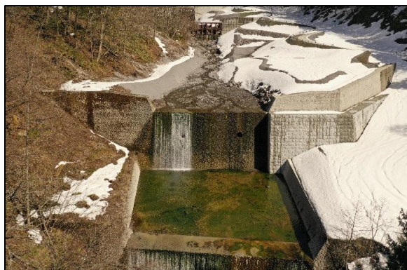
写真-1 白谷第1号砂防堰堤 着工前
