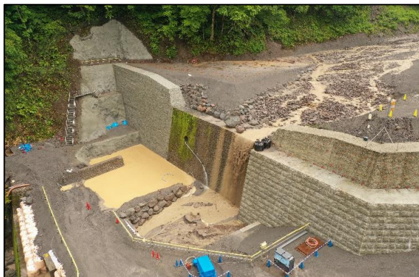
【写真-6 R4. 6. 21 土石流発生直後 施工箇所】
