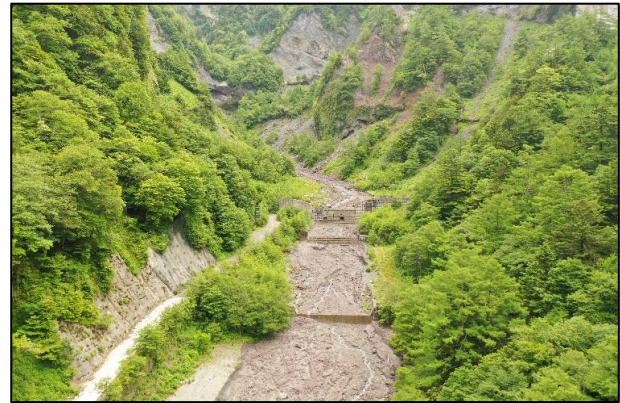
【写真-3 ドローンによる現地調査】
