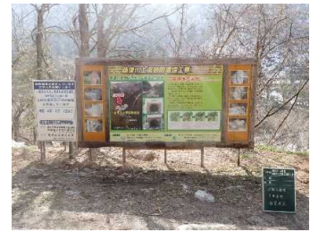
大型工事説明看板設置
