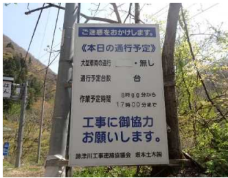
通行予定看板を設置
