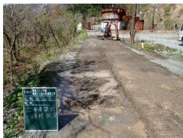
維持修繕作業
