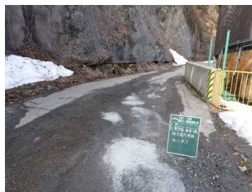
維持修繕作業
