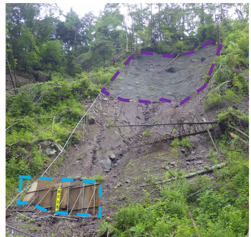
上流側の崩壊地の落石対策工
