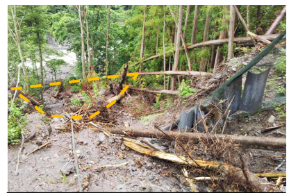
損傷した落石防護網 上流側半壊，下流側全壊(豪雨後)
