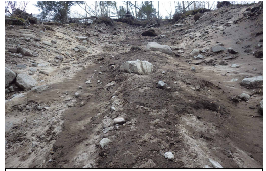
上流側崩壊地の地形
