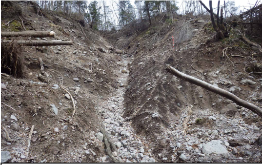
下流側崩壊地の地形
