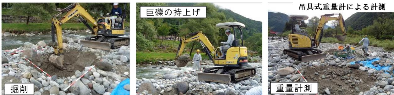
図-4 重機 (小型バックホウ) の使用
