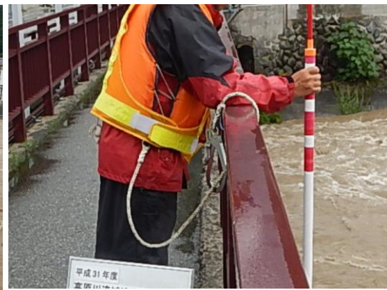
安全帯の使用（拡大写真）
