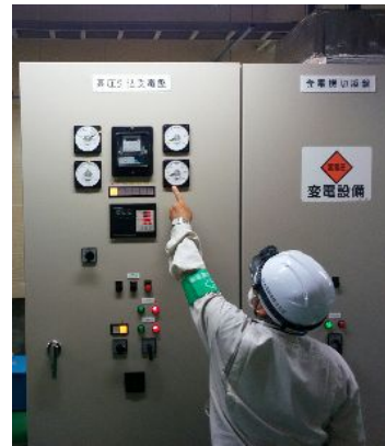
【計器類確認状況】
