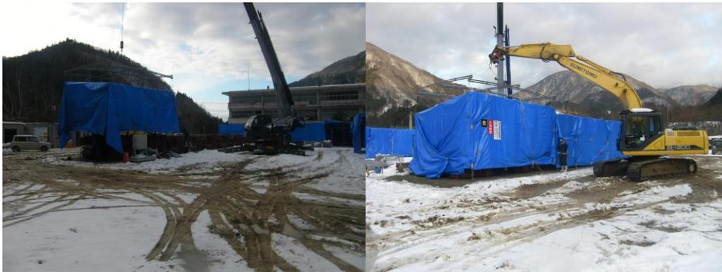
【レッカー・バックホウによる雪寒仮囲い設置・撤去状況】
