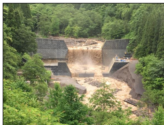
被災状況【写真－2】
