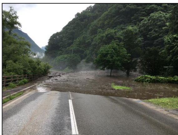
神坂地内の土砂流出【写真－1】
