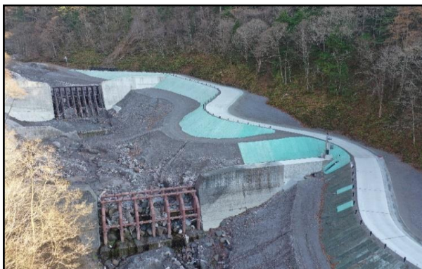
道路改良 完成 下流より上流を望む
