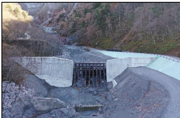
白谷第3号堰堤 完成 正面
