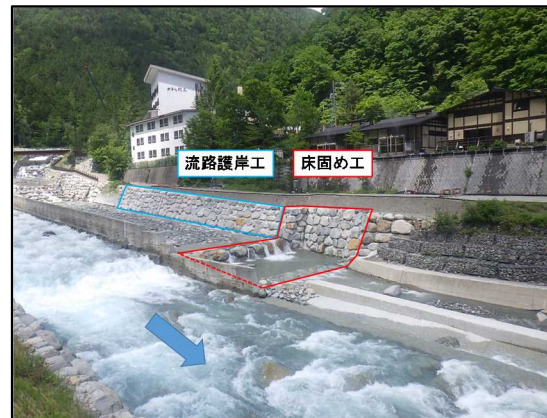
完成（蒲田川右岸下流側より望む）
