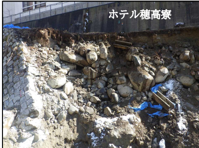
モルタル吹付施工前
