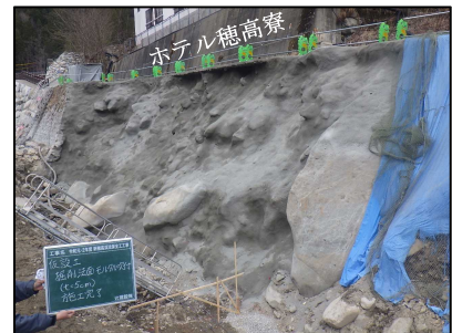
モルタル吹付施工後
