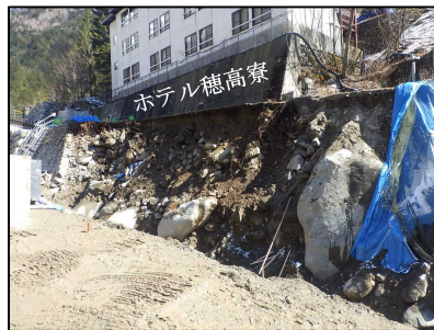
モルタル吹付施工前
