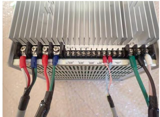
【写真8 直流電源装置端末処理完了】
