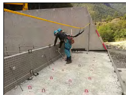
型枠組立【写真-3】
