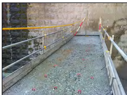
打設完了【写真-1】
