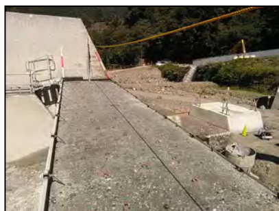
手摺撤去【写真-2】
