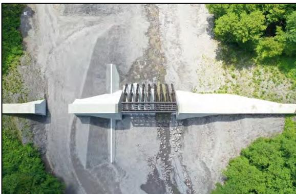
重力式擁壁（白谷3号堰堤）完成 上空より真下
