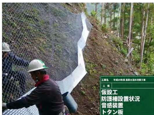
【写真－4 落石防護柵】
