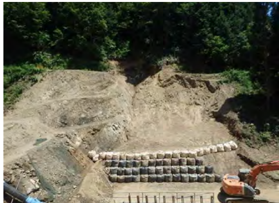
大型土のう設置抑え盛土
