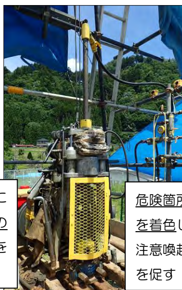
塩ビ管で作成したホースの回転止め
