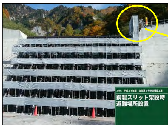
【鋼製スリット架設時 避難通路・避難場所】
