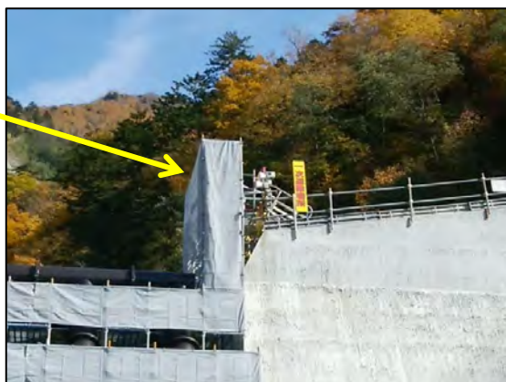
【鋼製スリット架設時 避難通路・避難場所】
