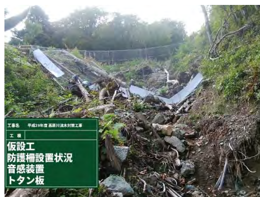
【写真－4 落石防護柵】
