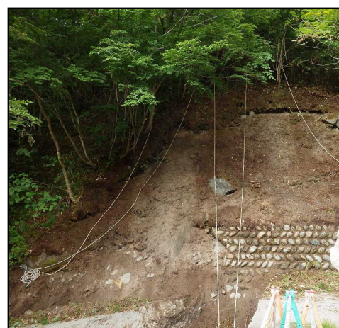
掘削箇所上部法面【写真-1】
