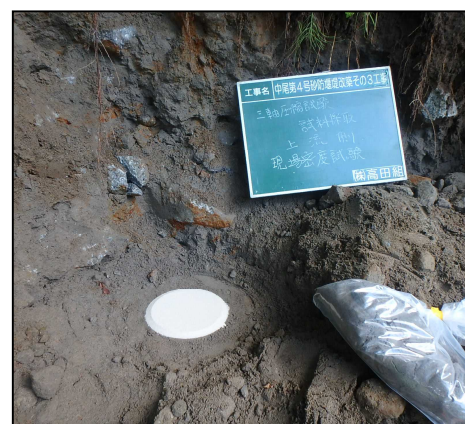
現場密度試験【写真-2】
