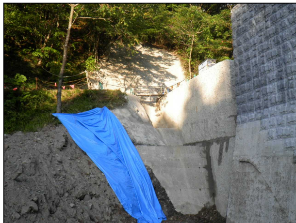
施工状況【写真-4】
