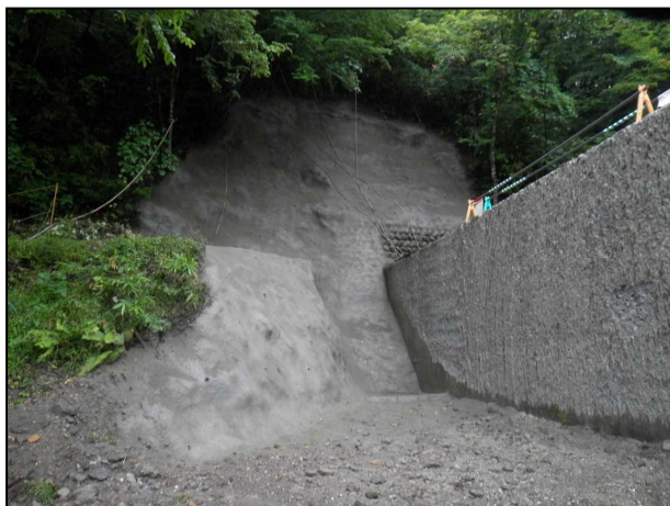
繊維入りモルタル吹付状況【写真-3】
