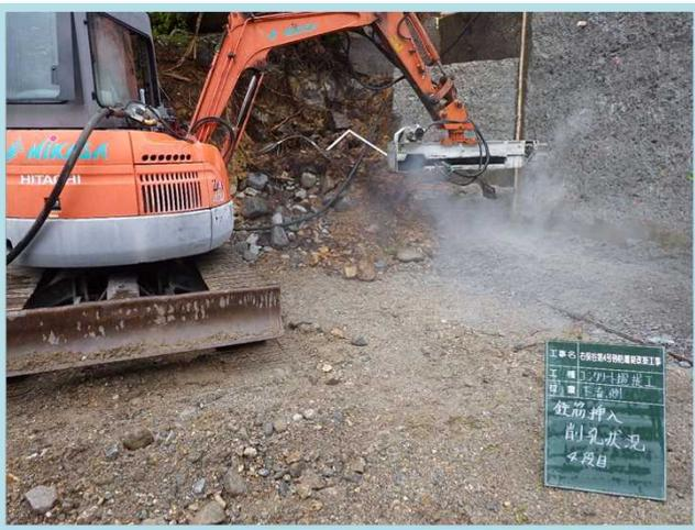
狭隘な箇所では施工が可能な小型バックホウを使用しました。機械施工堰堤本体工の工程を短縮することができました。
