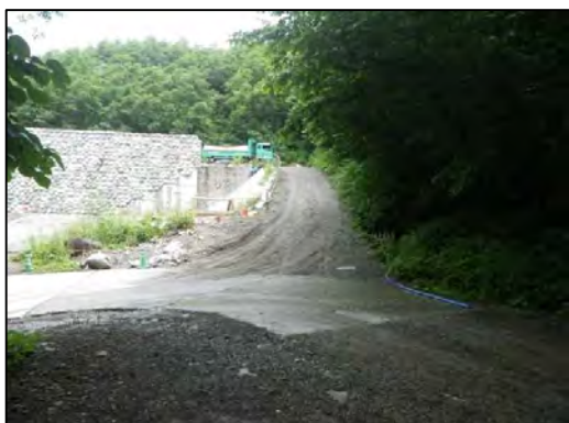
【路面散水状況1】
