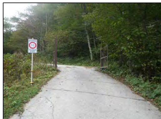
【工事用道路から一般道への合流点】
