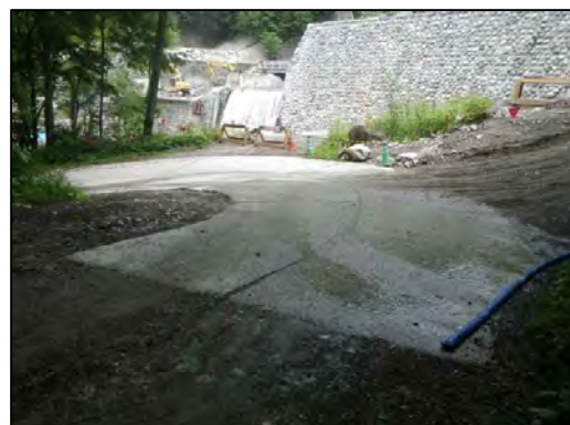
【路面散水状況2】
