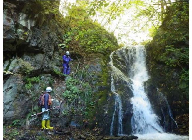
《安全ルート, 危険箇所の確認》 小さな滝となっていたため、上り下り用となるロープを設置
