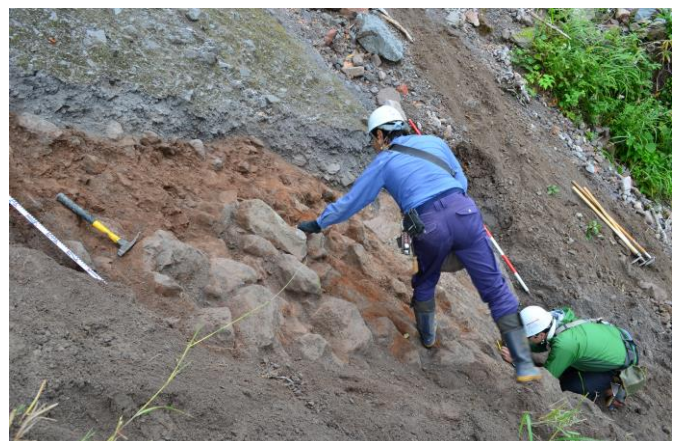
図 4.2 急斜面での作業状況
