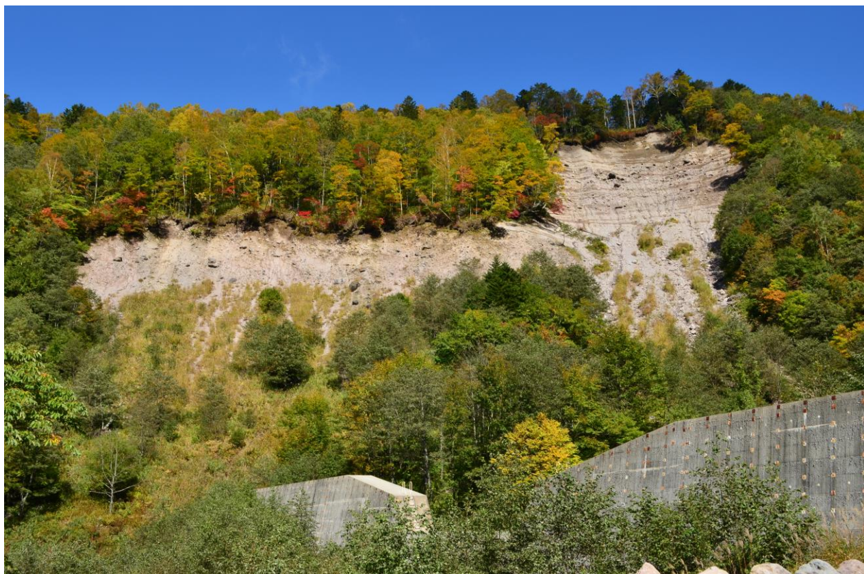
図 1.1 餌掛谷の大規模崩壊地
