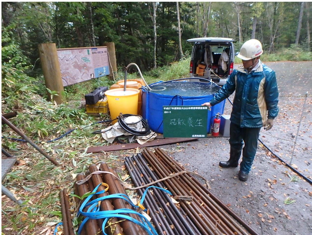
図 4.3 飛散養生対策
