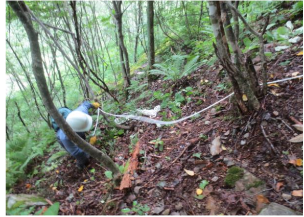
図 4.3 視察ルートへのロープ設置
