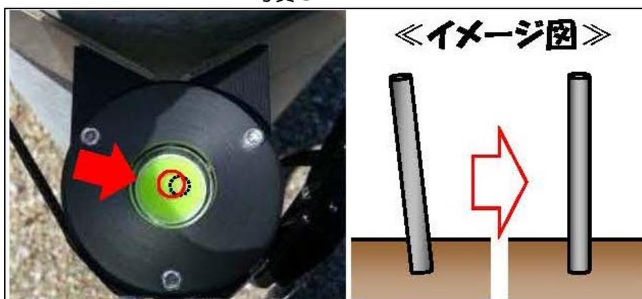
水平器の気泡を確認し、電柱の傾斜を直す。
