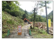
施工箇所前後に確認ゲートを設置し、現場内に架空線があることを周知しました。また、 現場内では作業員にわかりやすいよう、▽旗、のぼり旗により架空線位置を明示しました。 伐採、クレーン作業等の近接作業時は見張り人を配置し、切断事故を防止しました。
