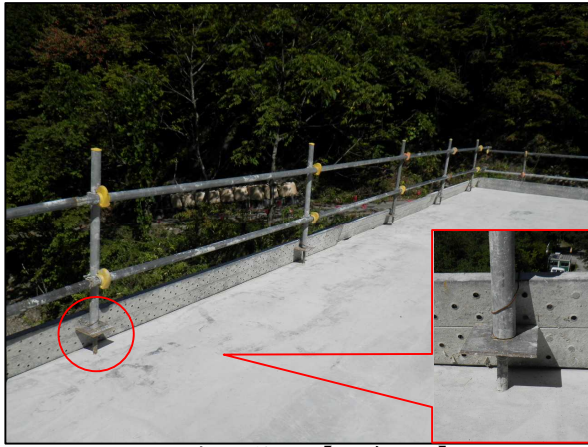
コンクリート打設状況【写真-6】
