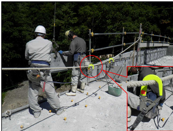
型枠組立状況【写真-8】
