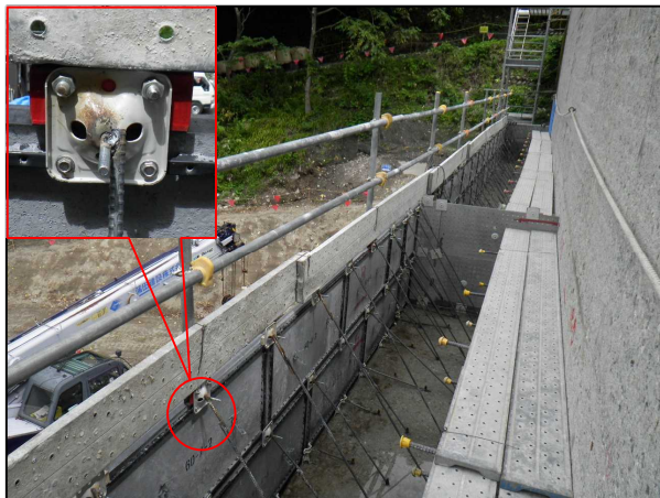
型枠専用取付金具【写真-2】
