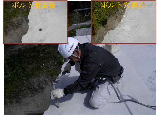
撤去状況【写真-7】
