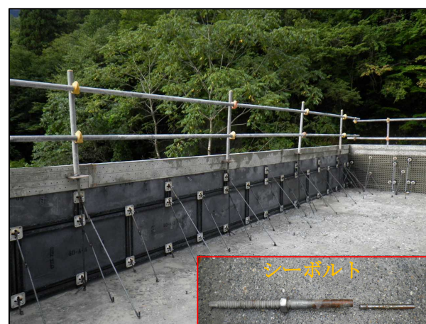
手摺設置状況【写真-5】
