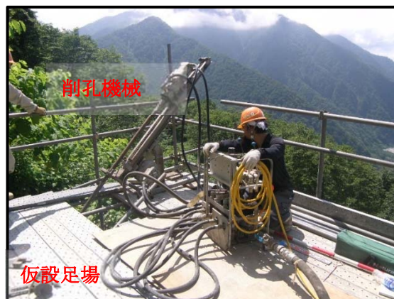
【図-2 足場上での削孔作業】
