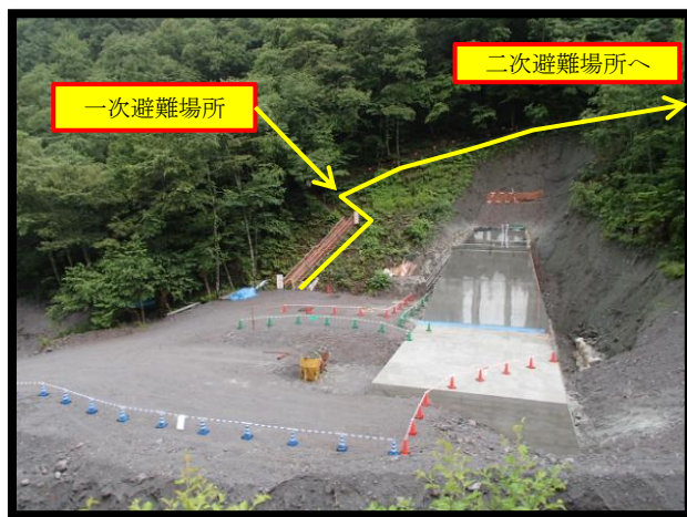
[避難経路全体写真]
