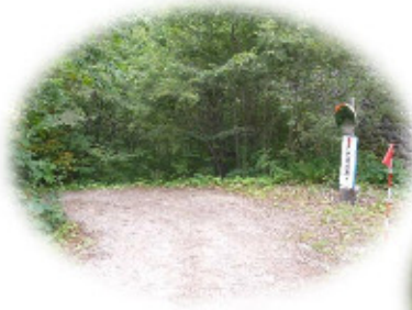
現場付近の設置状況
