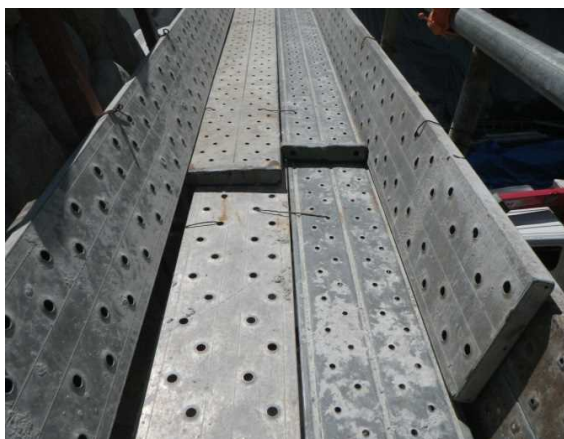
【足場の内側にも幅木を設置した】
