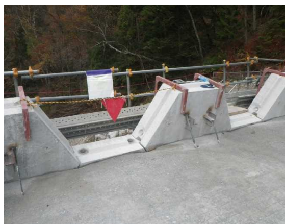
【型枠の内側からの進入を防止するためトラロープにて明示し注意喚起した】
