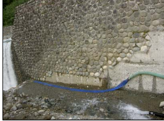
修景ブロック既設状況②
