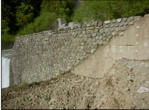
修景ブロック既設状況①
