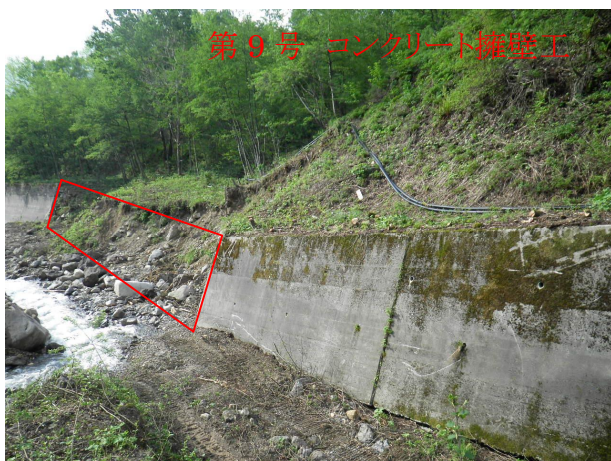
(第9号 コンクリート擁壁位置)
