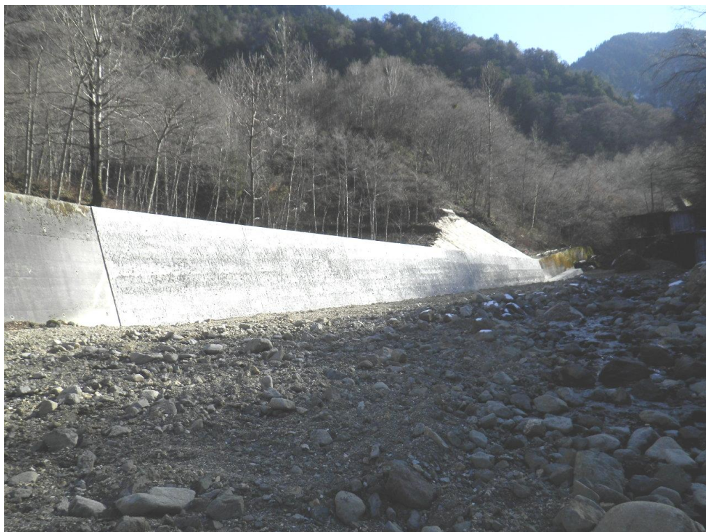
第 9 号完成写真
