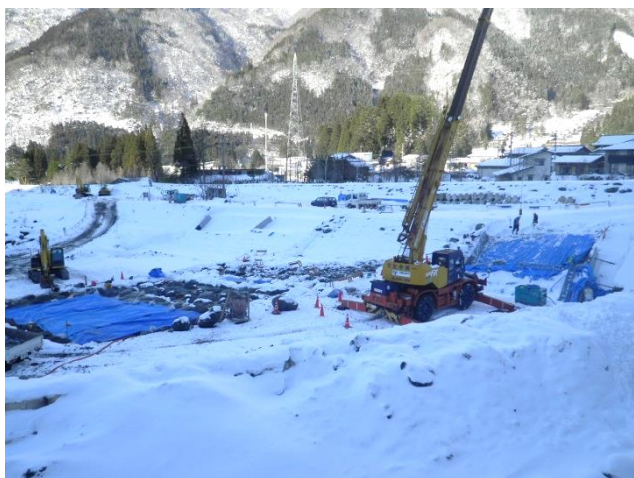
工事作業状況（全景）
