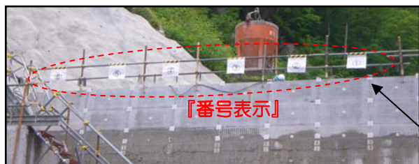
型枠外側より
