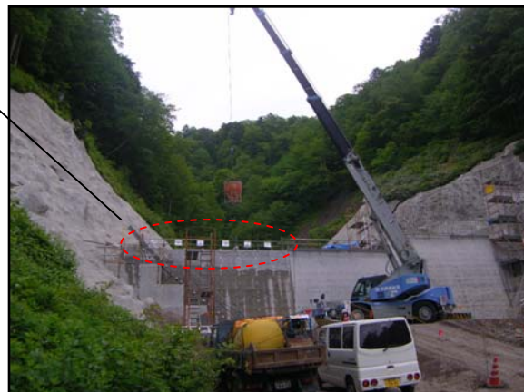
コンクリート打設状況
