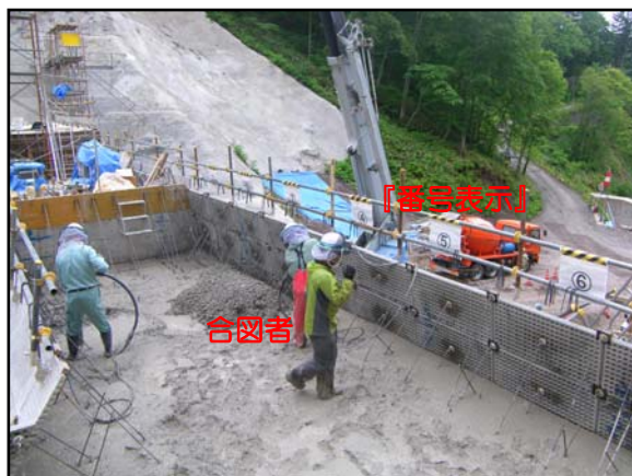
型枠内側より
