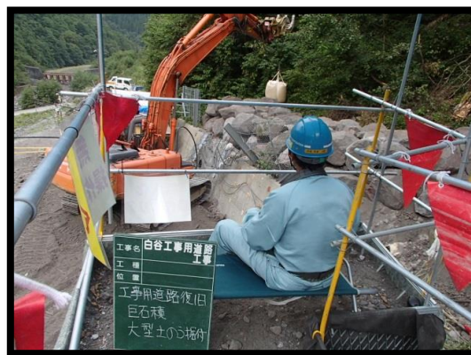
(大型土のう据付状況)
