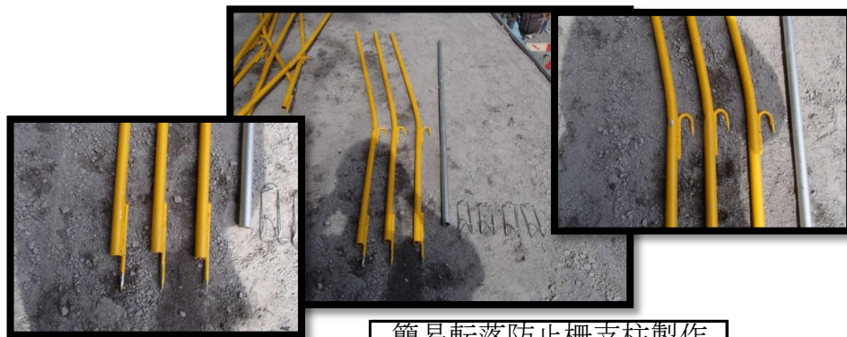
簡易転落防止柵支柱製作
