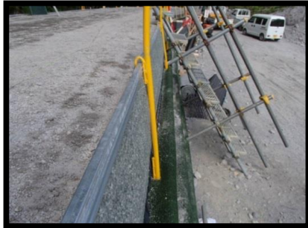
(支柱立て込み状況)
