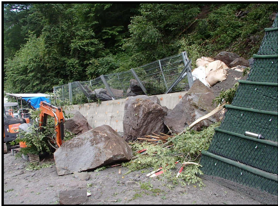
〔落石による被災状況〕
