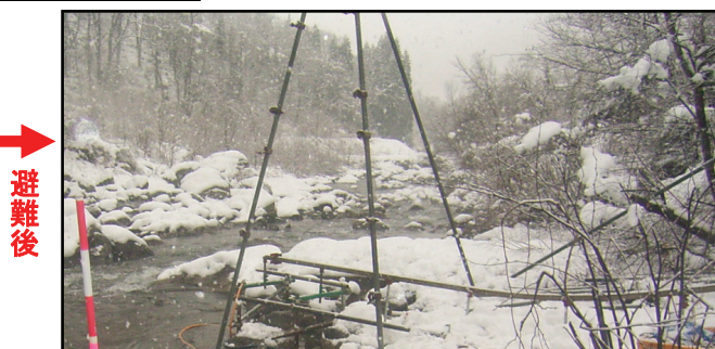
写真4. 右:マシン避難後のボーリング地点には、 単管パイプ等が残るだけである 。
