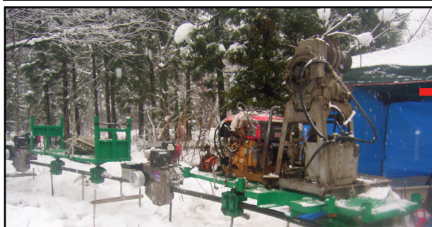
写真3. 左:モノレール台車一体型移動式 ボーリングマシンの避難状況
