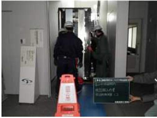
写真3. 機器搬入状況 (プラスチックダンボール養生、ハンドリフト使用状況)
