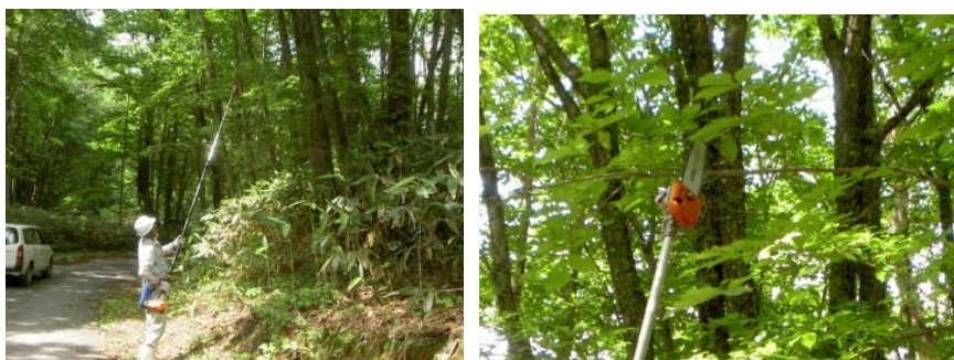
道路上に張り出した枝葉、つる等の除去（長尺形チェーンソー）
