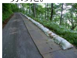
敷鉄板による路肩及び横断側溝の保護
