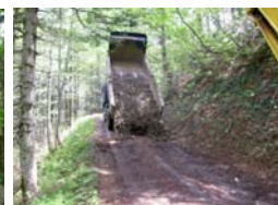
不良箇所の補修
