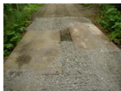
敷鉄板による路肩及び横断側溝の保護
