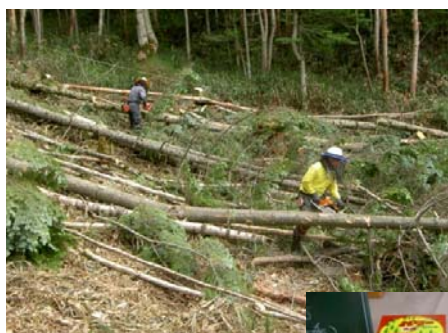
伐採作業状況
