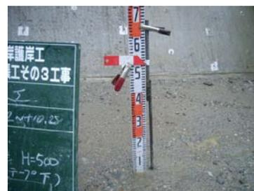
↑ 打設厚さ確認用鉄筋 設置状況
