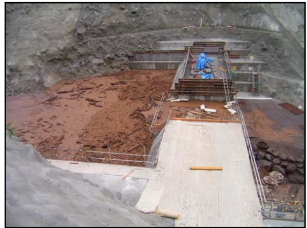
土石流発生後
