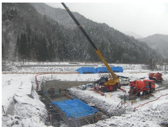
工事作業状況（全景）
