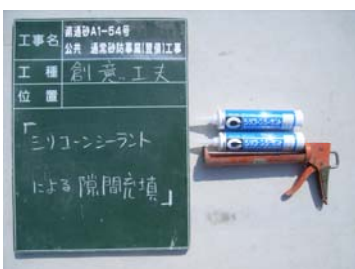
《シリコンシーラントによる隙間充填》
