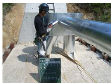
《シリコンシーラントによる隙間充填》
