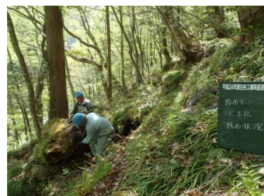
〔写真-3 浮石の除石状況〕
