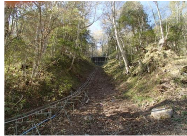
〔写真-9 モノレール設置ルート〕
