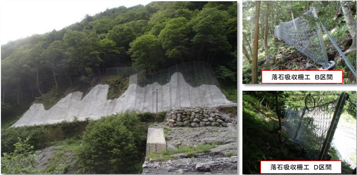
〔写真-1 平成25年度施工箇所〕
