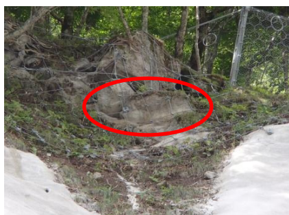
〔写真-8 巨大転石基部モルタル吹付〕
