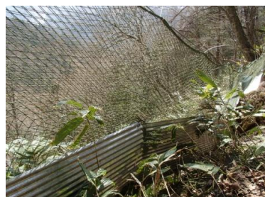
〔写真-4 仮設落石防止網設置〕
