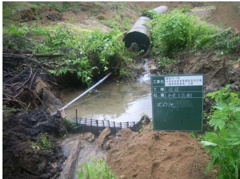
写真3 沈砂池の設置
