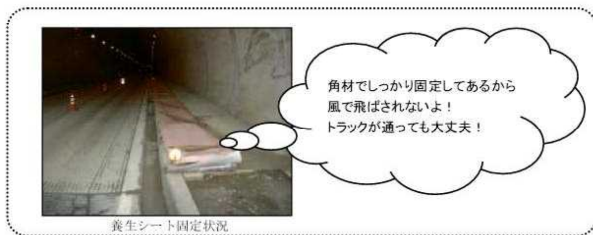
写真-4 養生材の角材を使用した風剥防止対策
