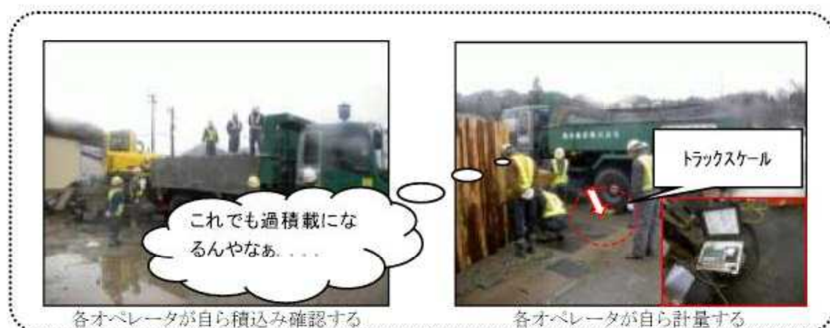
写真-5 トラックスケールによる過積載防止訓練
