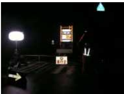
国道 471 号線の夜間通行止め
