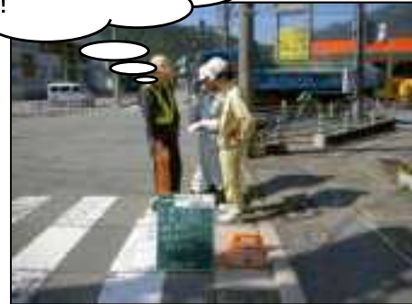
埋設物探索状況
